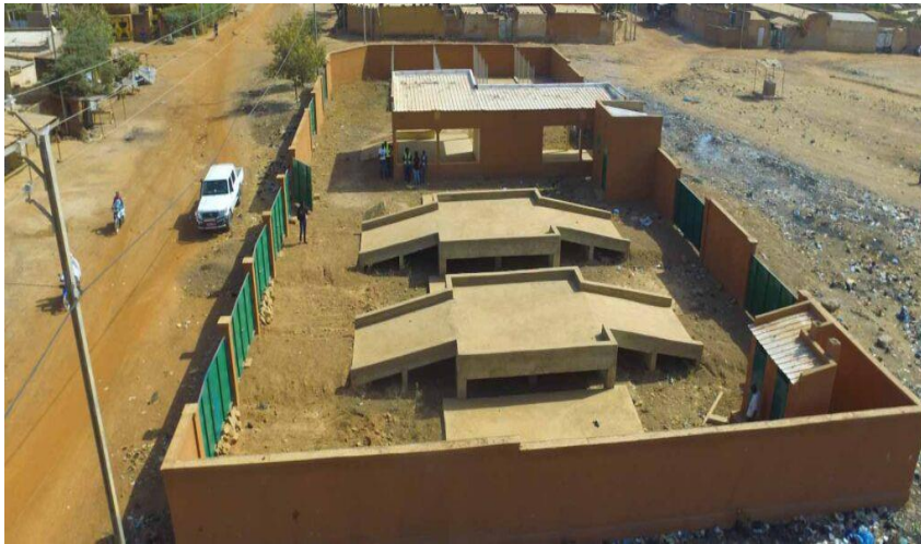
Photo 1 : un centre de collecte et de tri des déchets solides (vue aérienne)
