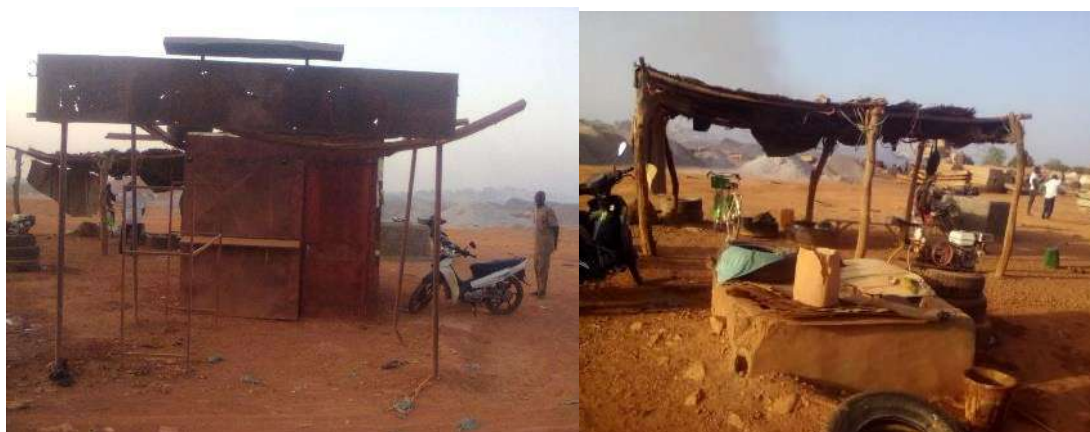
Photo 3: Photos d'infrastructures impactées
