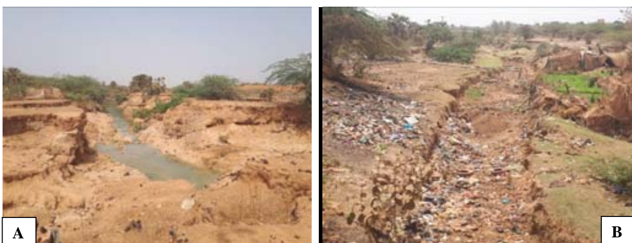
Photo 4: Aperçus de deux sections du tronçon de cours d'eau en amont de la RN4 (A) et (B)
