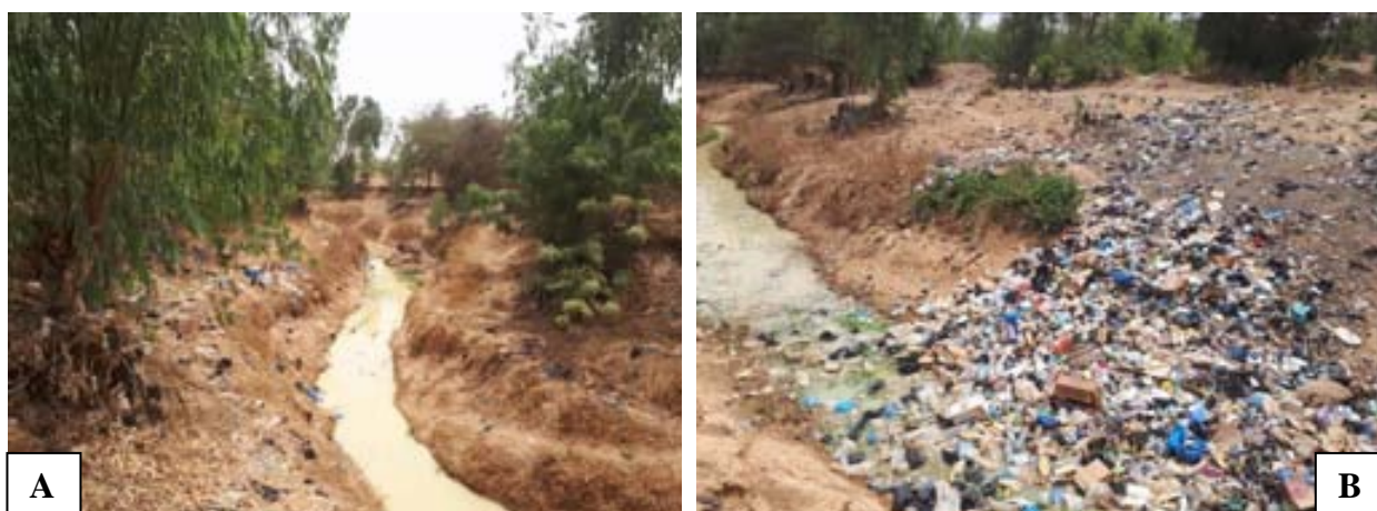
Photo 8: Aperçus du tronçon de l'affluent 2 longeant des arbres (A) et d'un dépotoir d'ordures ménagères dans le lit de l'affluents (B).
