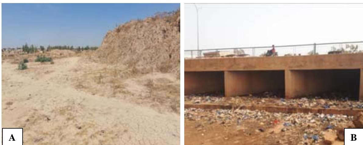
Photo 1: Aperçus de la confluence du Marigot de Goudrin et du marigot Kadiogo (A) et de la fin du tronçon du marigot de Goudrin au niveau du dalot de la RN4 (B)
