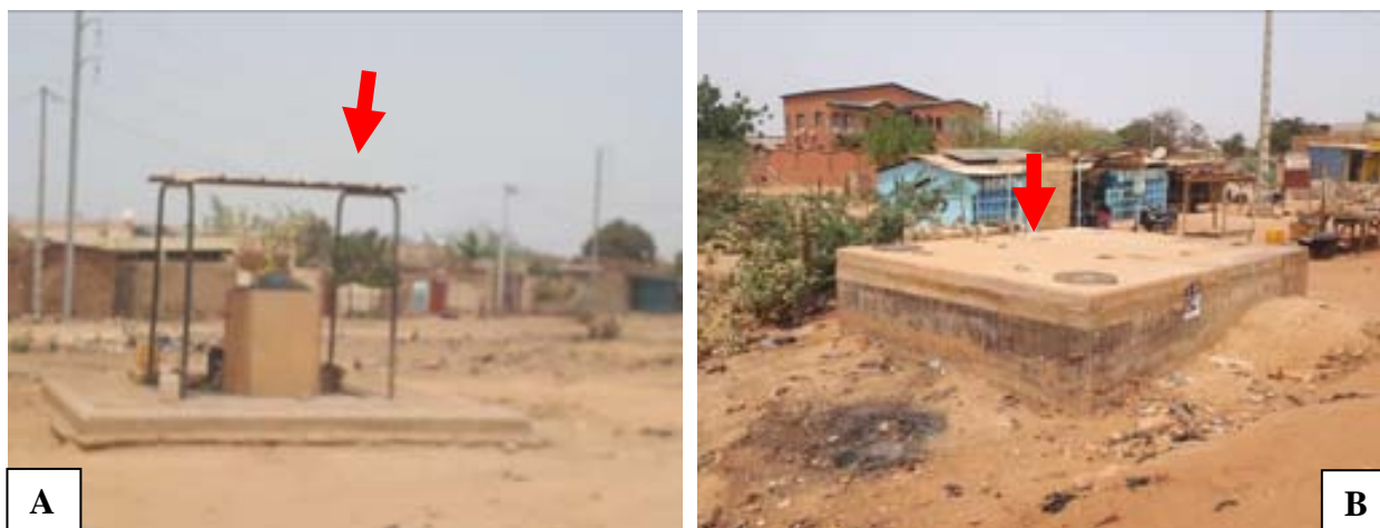
Photo 18: Aperçu d'une borne fontaine (A) et d'un regard (B) de l'ONEA longés par l'affluent 2.
