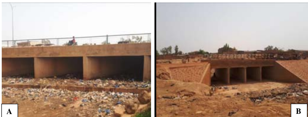
Photo 22: Vues des ouvrages de franchissement du marigot de Goudrin (A) et de l'affluent 2 (B) sur la RN4.
