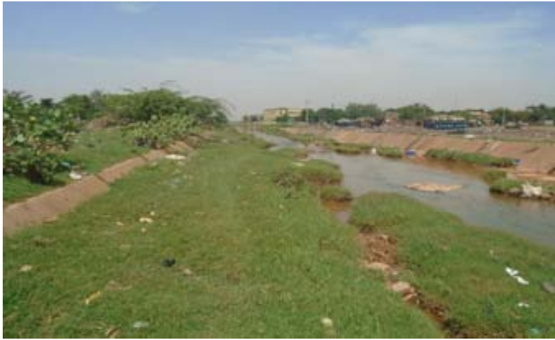
Dépôt de vase et d'ordures dans le canal dans la zone de Ouidi
