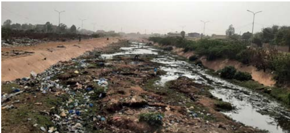
Photo 13:Image du canal construit dans le site du second bassin de rétention
