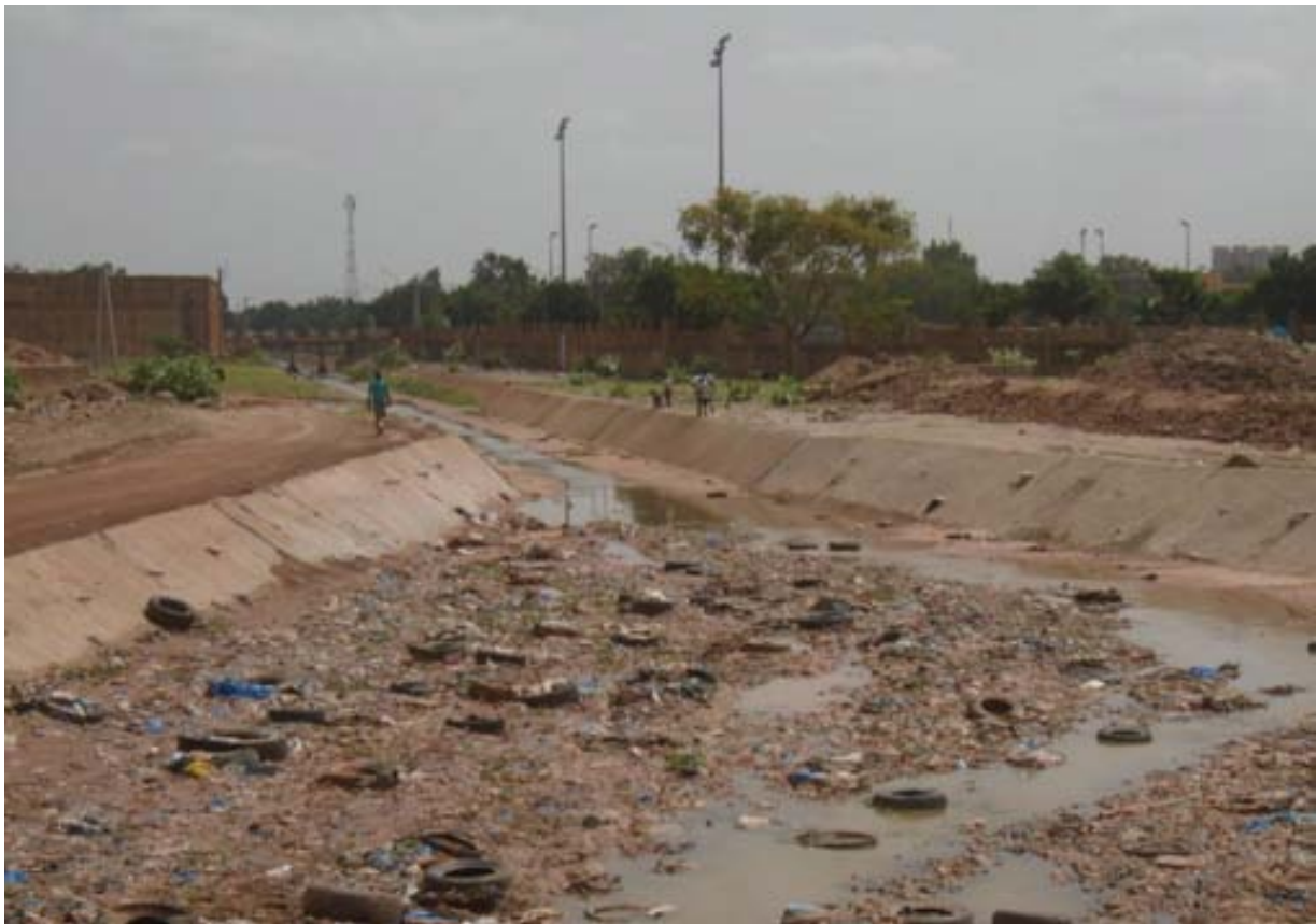
Photo 5: Point de jonction des deux canaux
