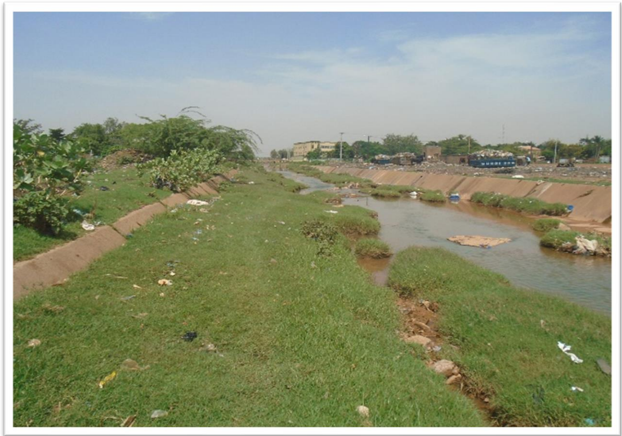
Photo 1: Dépôt de vase en aval du site du bassin de rétention
