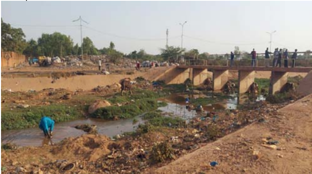
Photo 10 : Zone du bassin de rétention
