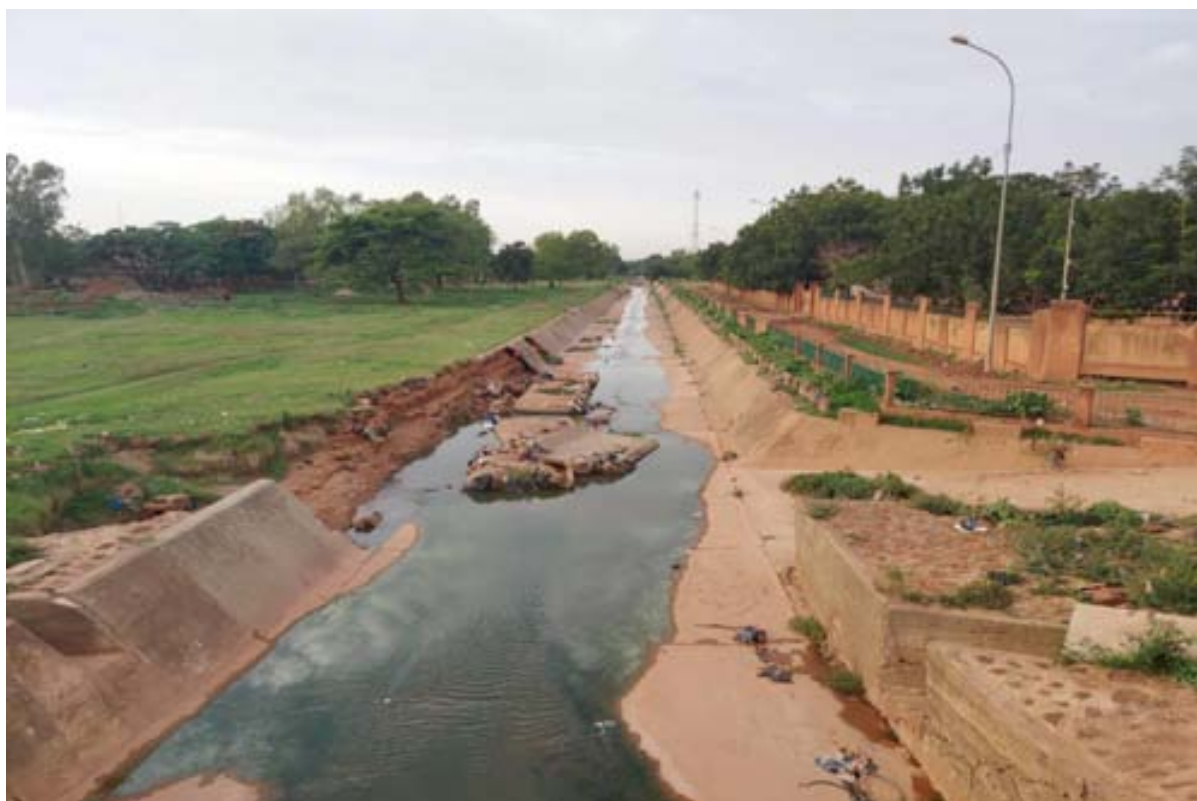
Photo 6: Etat des infrastructures en aval du site
